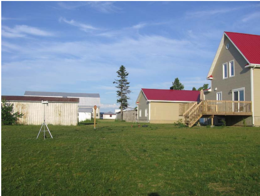
Figure B-4 : Photo 2 du point 2 (50, chemin de la Grande Ligne)
